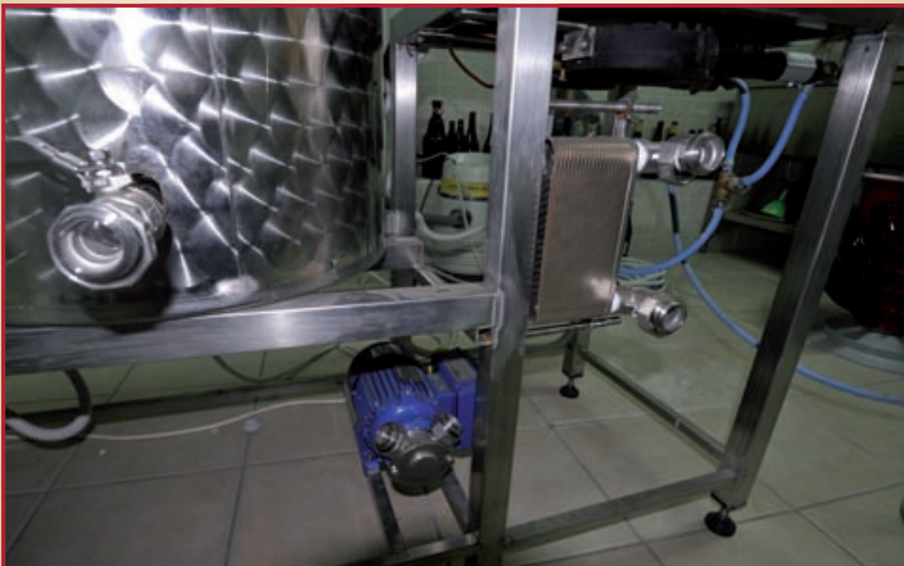
Ecco la pompa installata nella struttura del mio impianto.
